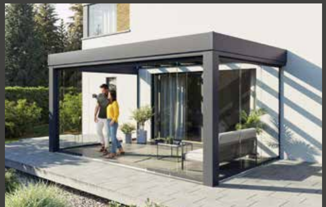
Terrassendächer Terrace Roofs
